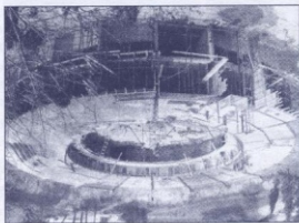
Планетариумът в гроб строеж. Завършено е всичко, без външния покривен купол с носеща решетка от части, които влизат в комплекта на апаратурата.
